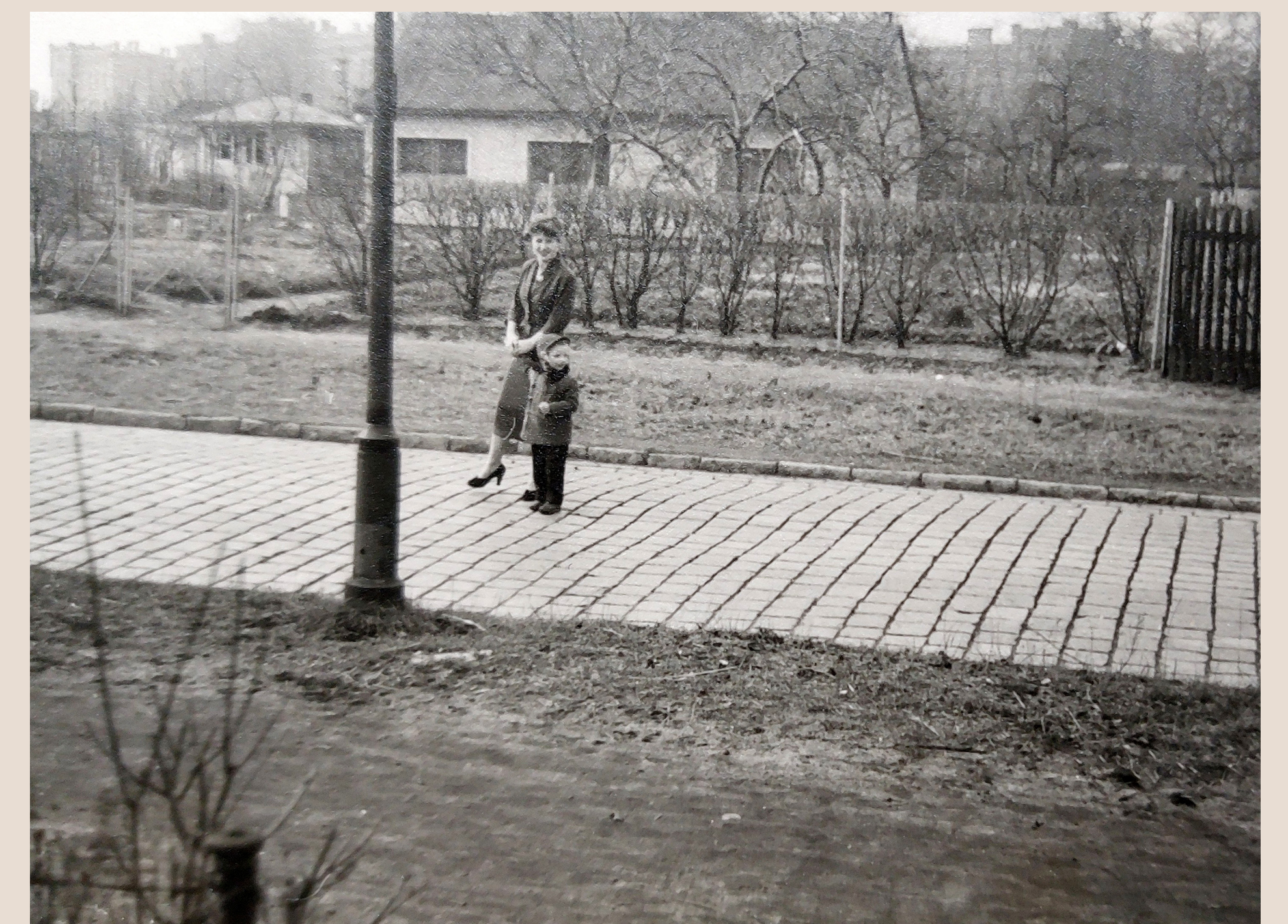
Blick über die Gatower Straße nach Westen
