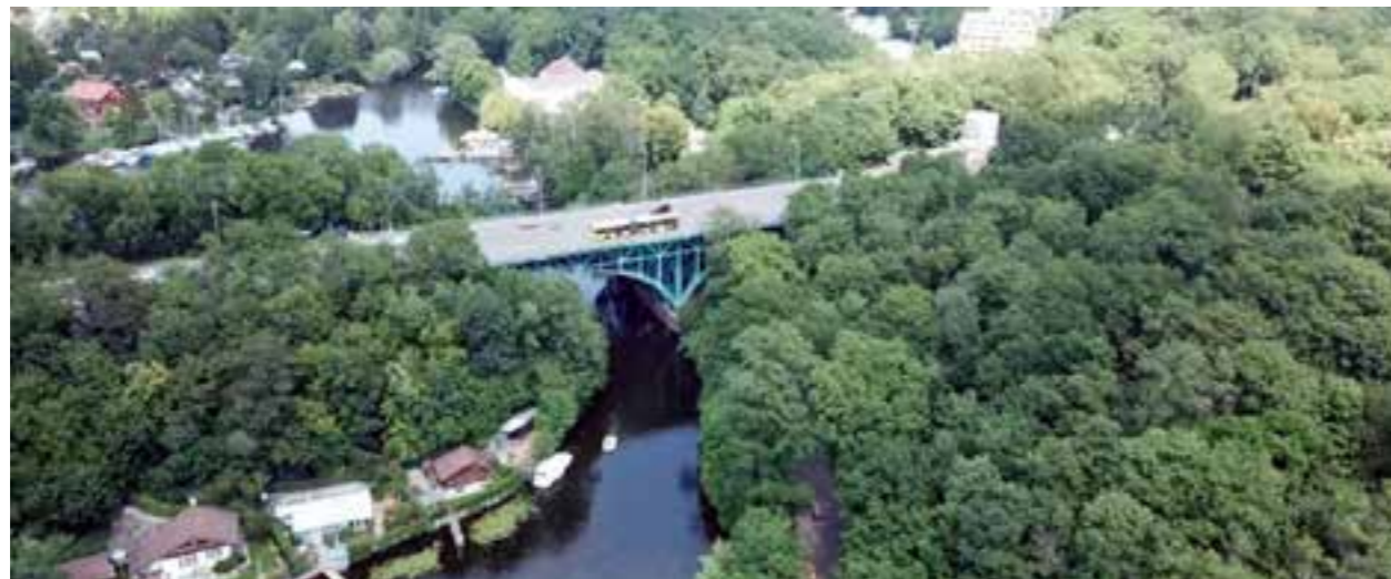
Die Stößenseebrücke heute
